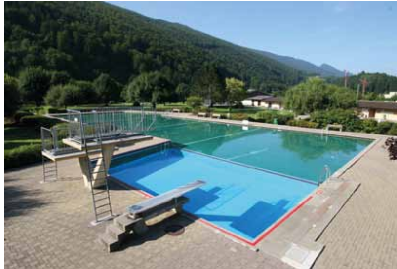
Unsere Badi vor der Sanierung
